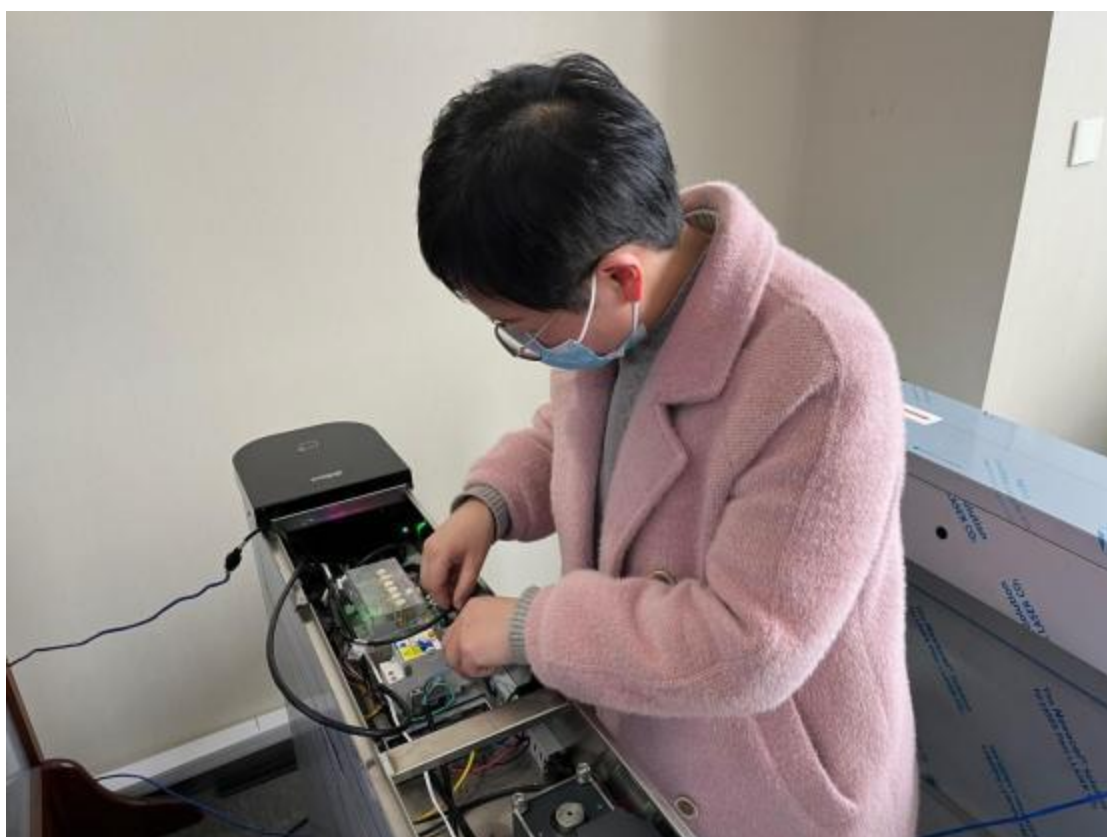
图 6-3 教师在实践站企业进行道闸系统安装调试
